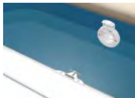
Hebilla antilevantamiento sobre enrasado con soporte de escuadra
